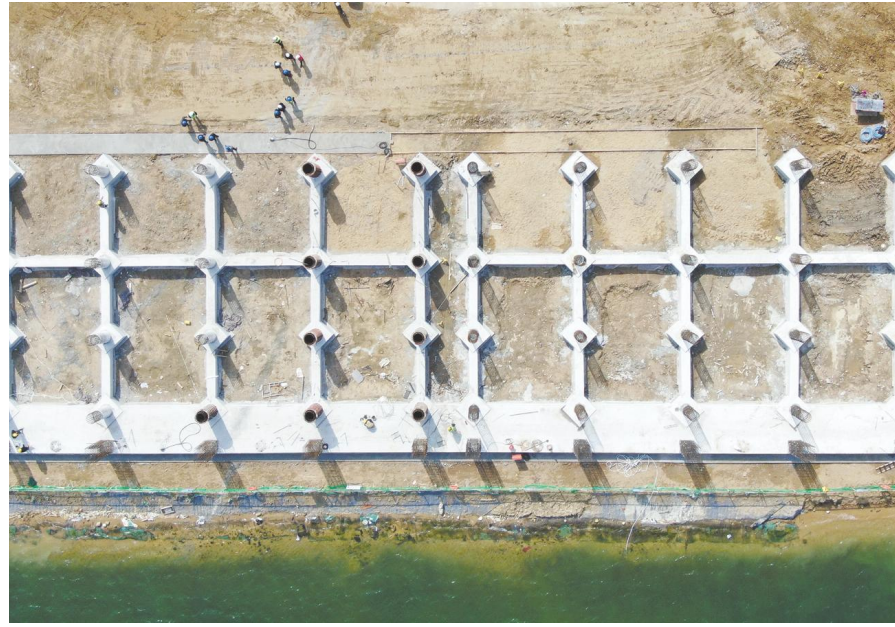
南昌昌东港区下尾万家作业区码头项目施工现场
