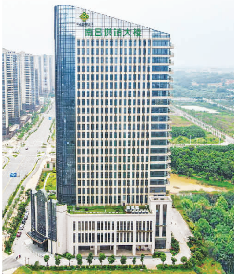
南昌供销大楼地处南昌西站核心商务区，占地面积12.186亩，地下2层，地上23层，总建筑面积45000㎡，已于2020年底投入使用。
